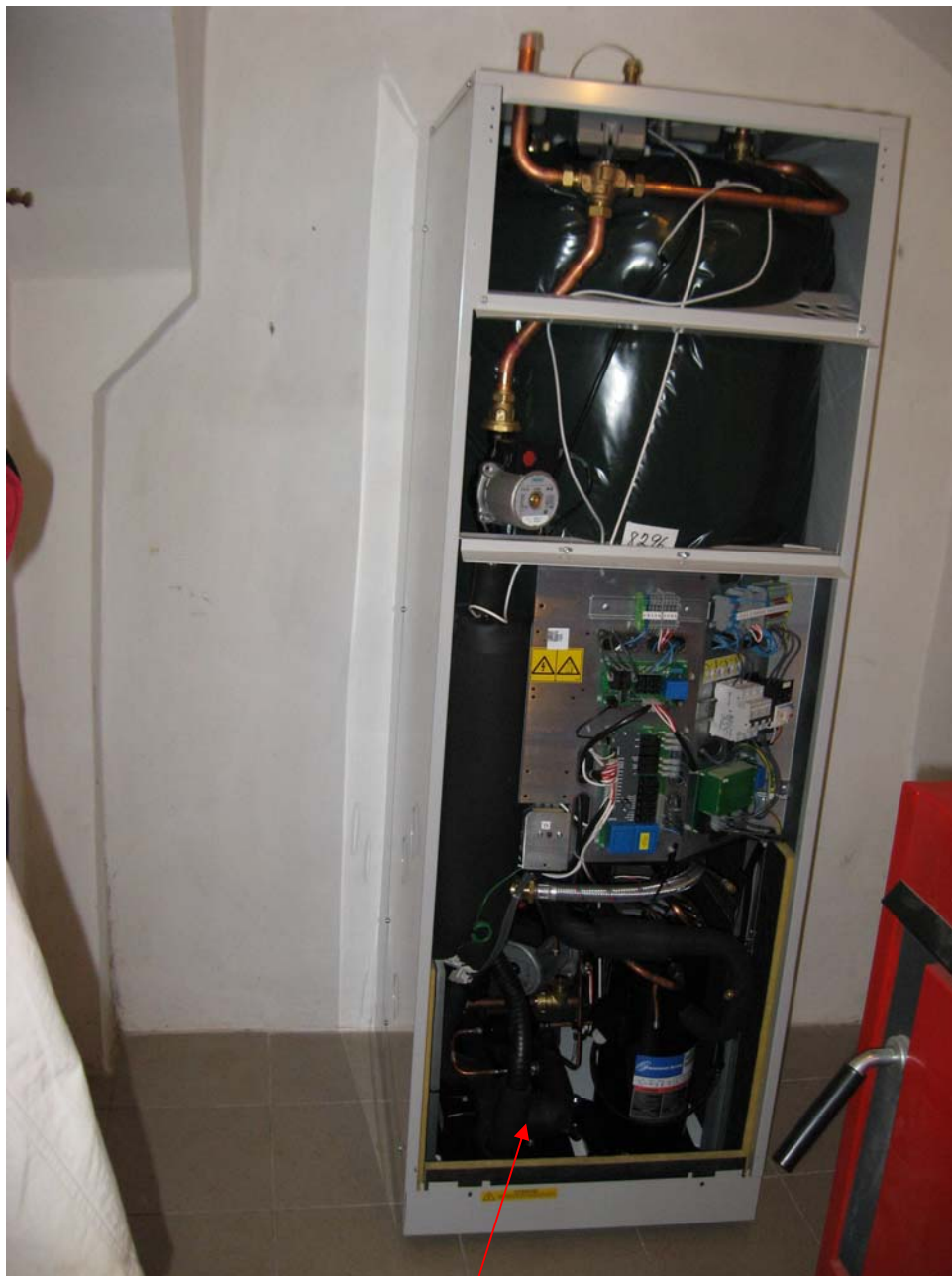
Svod kondenzátu s odkapávačem a výstupem do odpadu
